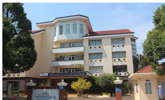
Nhà máy Thủy điện Buôn Kuốp
