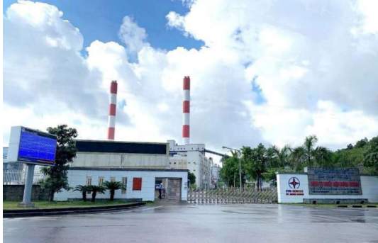
Nhà máy Nhiệt điện Mông Dương 1
