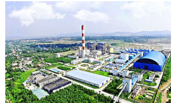
Nhà máy Nhiệt điện Đông Triều
