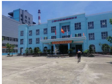
Nhà máy Nhiệt điện Nông Sơn
