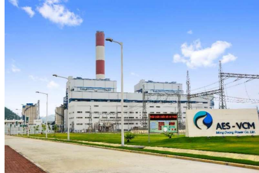
Nhà máy Nhiệt điện Mông Dương 2
