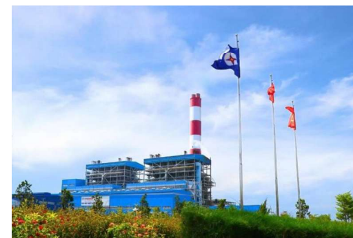
Nhà máy Nhiệt điện Vĩnh Tân 2
