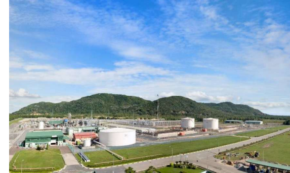
Nhà máy khí NCSP
