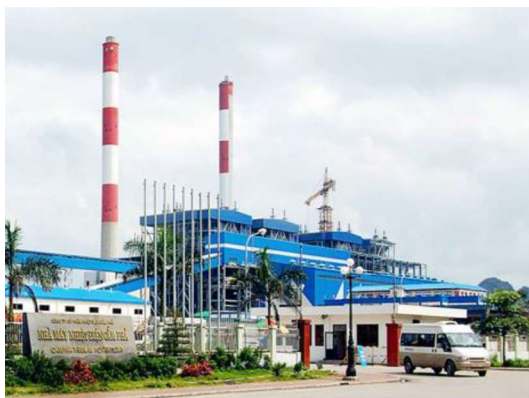
Nhà máy Nhiệt điện Cẩm Phả
