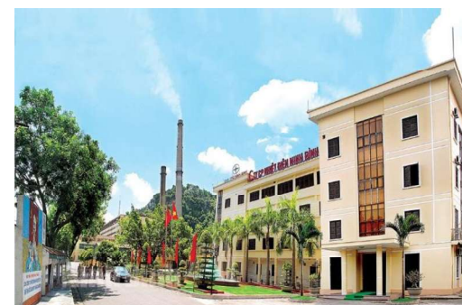
Nhà máy Nhiệt điện Ninh Bình
