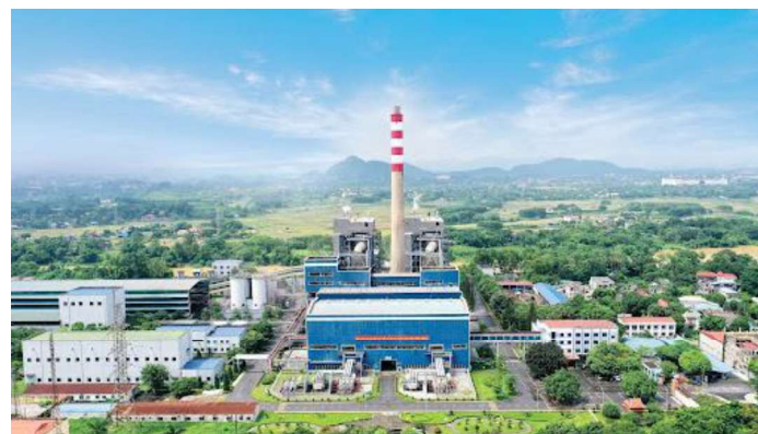
Nhà máy Nhiệt điện Cao Ngạn
